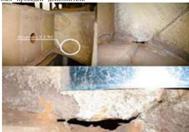
Рис. 3 – Дефект в области соединения главной балки №1 и концевой балки №2
