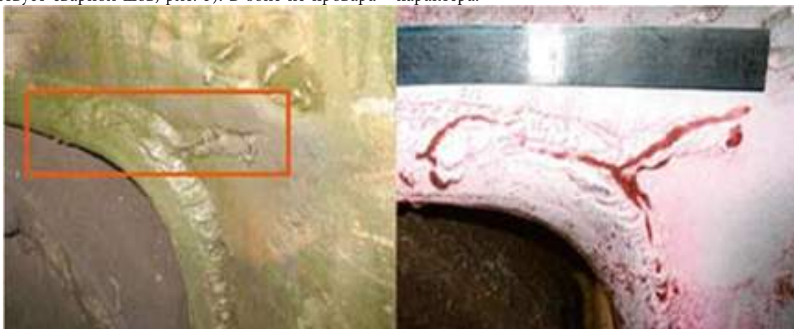
Рис.4 – Трещина в области буксового узла, источник АЭ №2
