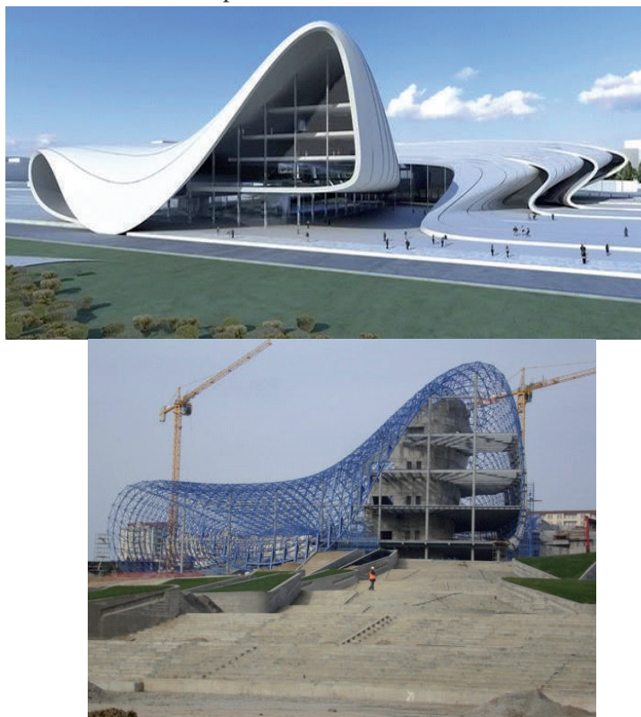
Рис. 3. Театрализация архитектуры сегодня. Скрытая конструкция и автономная внешняя оболочка. Центра Гейдара Алиева, арх. З. Хадид, Баку, Азербайджан, 2007-2012 гг.
