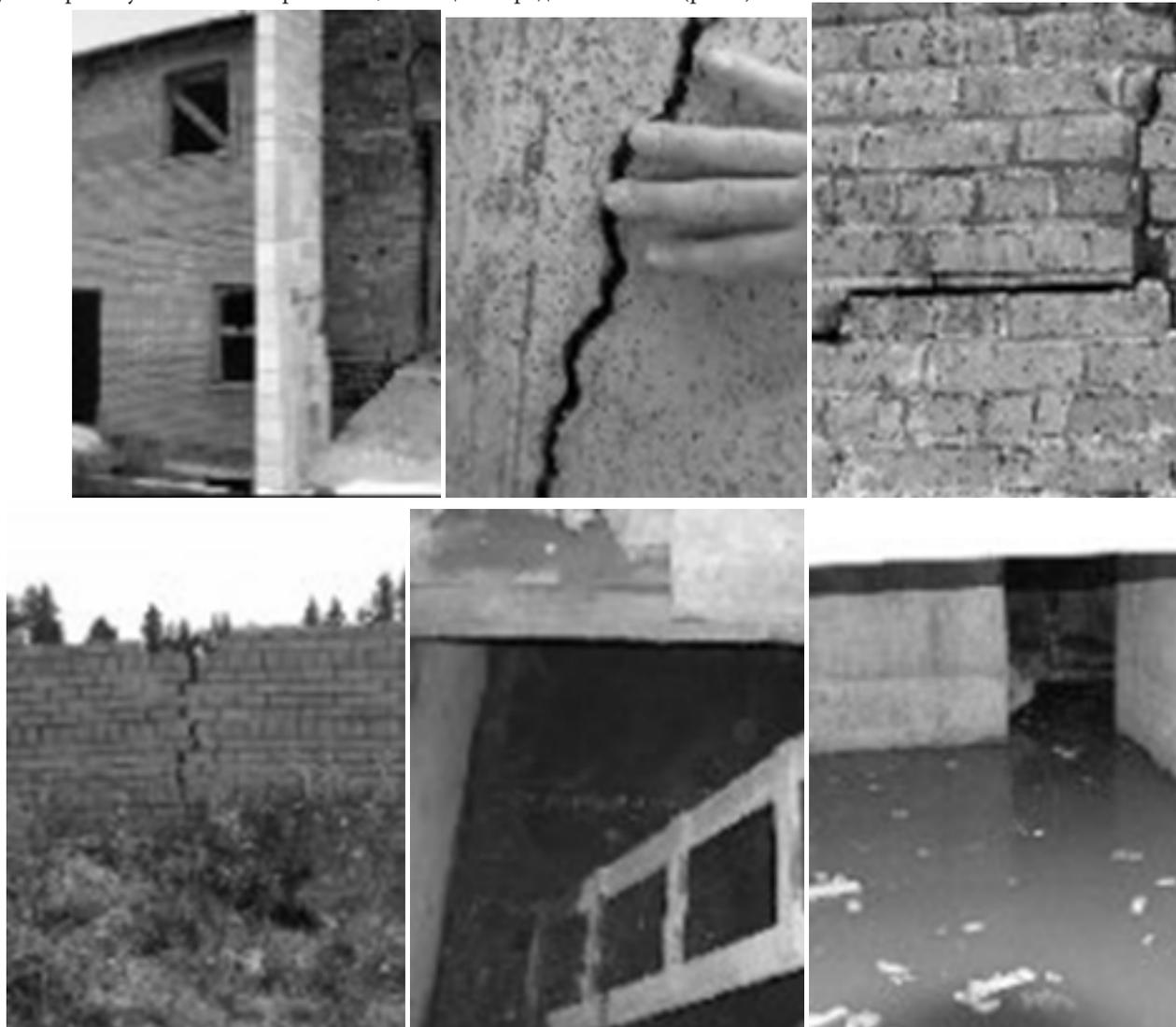
Рисунок 1. Примеры процессов, происходящих с зданиями, при не проведении инженерных изысканий
