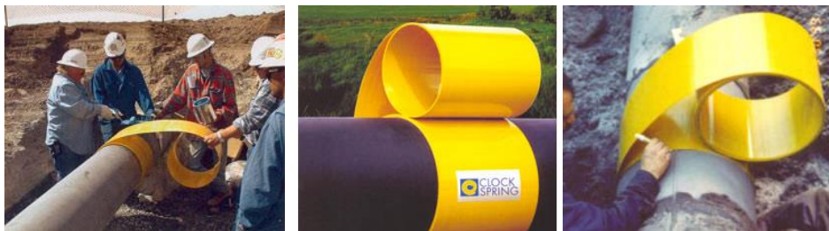
Рисунок 1 – Монтаж муфти Clock Spring
