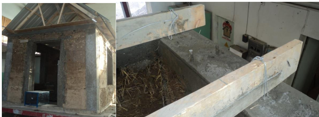
Рис. 5. Процесс возведения модели дома из “железобетонного каркаса”
