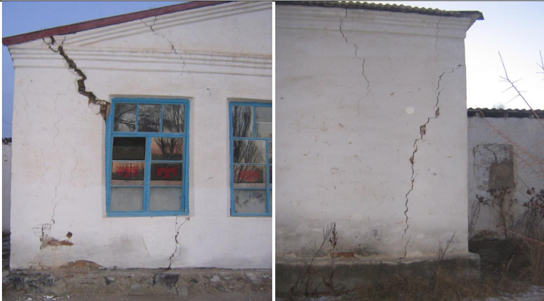
Рис.7. Кочкорское землетрясения 2007г, с. Кара-Тоо, здание сельского клуба
