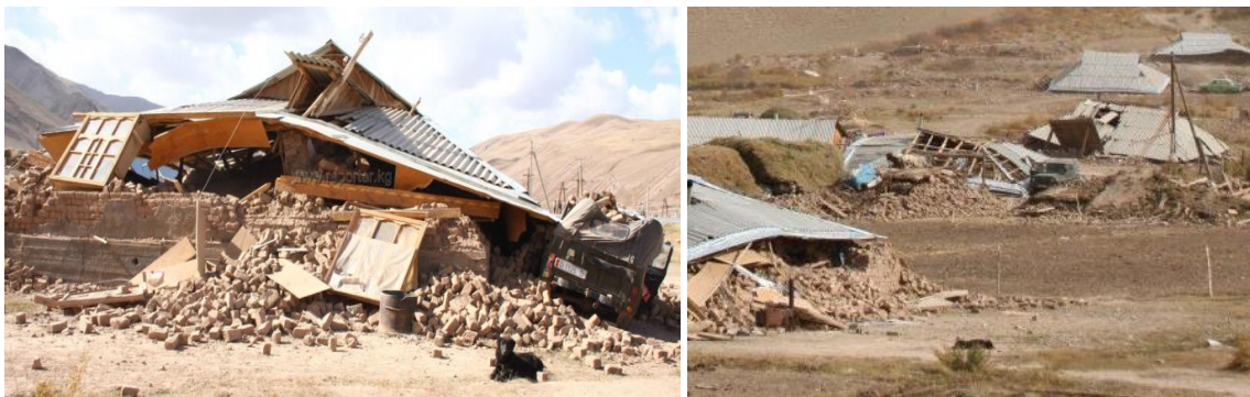
Рис.8. Состояние домов после землетрясения в с. Нура -2008 г.
