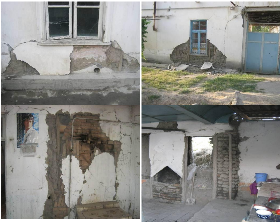
Рис. 9. Повреждения стен сынчевых зданий при землетрясении 20.07.2011 г.
