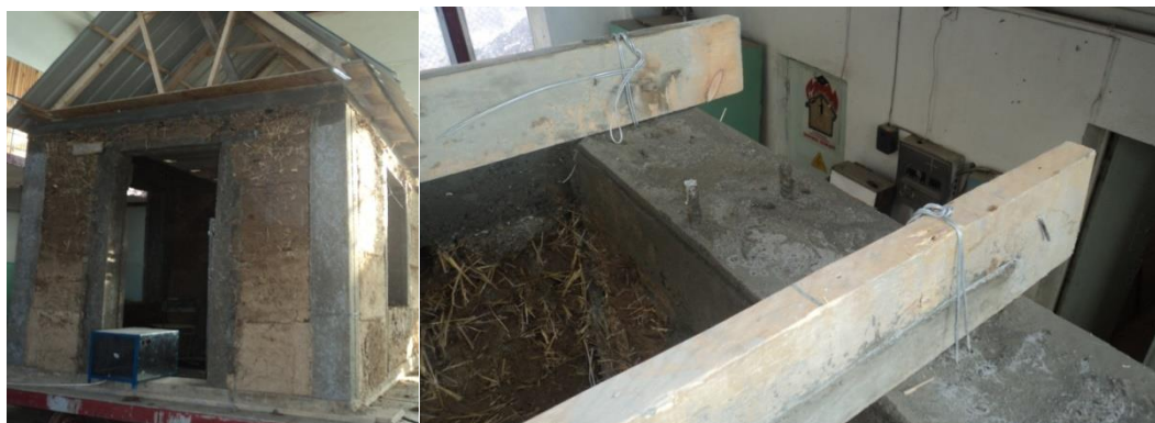
Рис. 5. Процесс возведения модели дома из “железобетонного каркаса”
