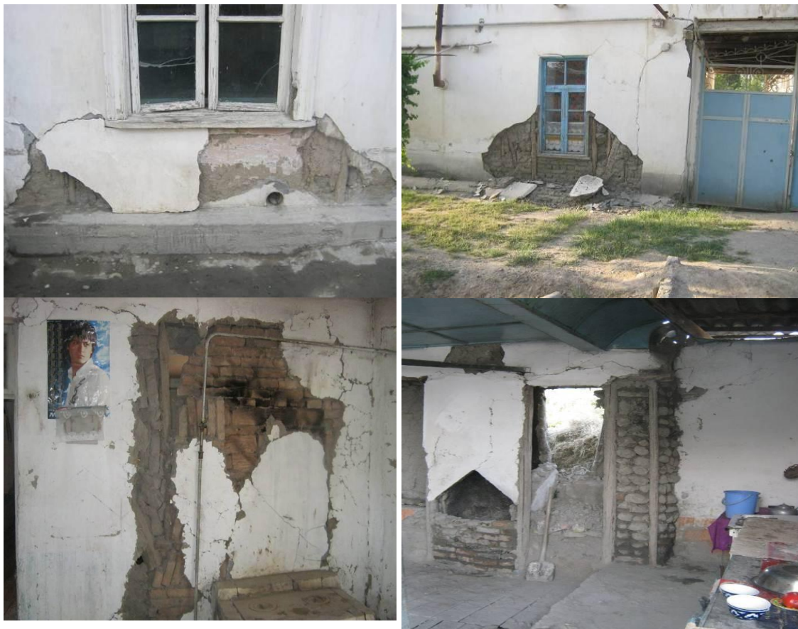
Рис. 9. Повреждения стен сынчевых зданий при землетрясении 20.07.2011 г.
