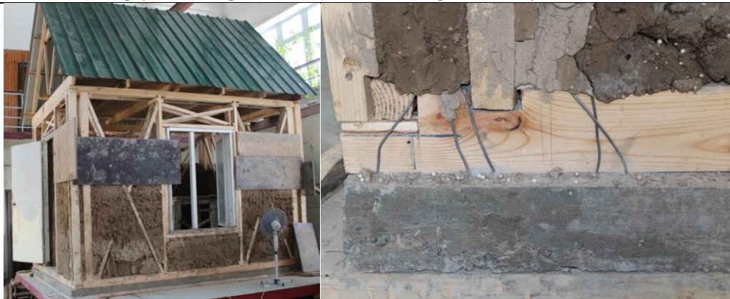
Рис. 3. Процесс возведения модели дома из деревянного каркаса “Сынч”
