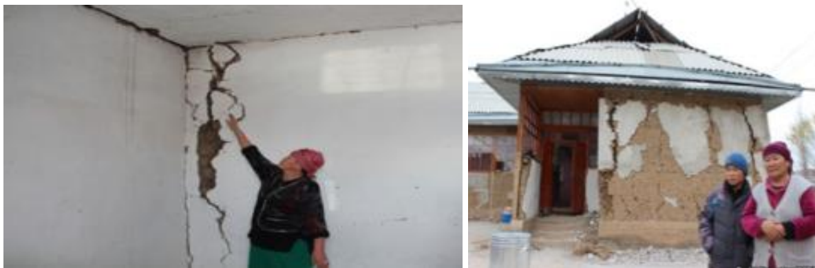
Рис.10. Состояние домов после землетрясения в Карасууйском районе -2015г.
