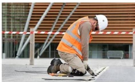
*Рисунок 1. Разработка дорожного покрытия с использованием встроенных электропроводящих элементов*
