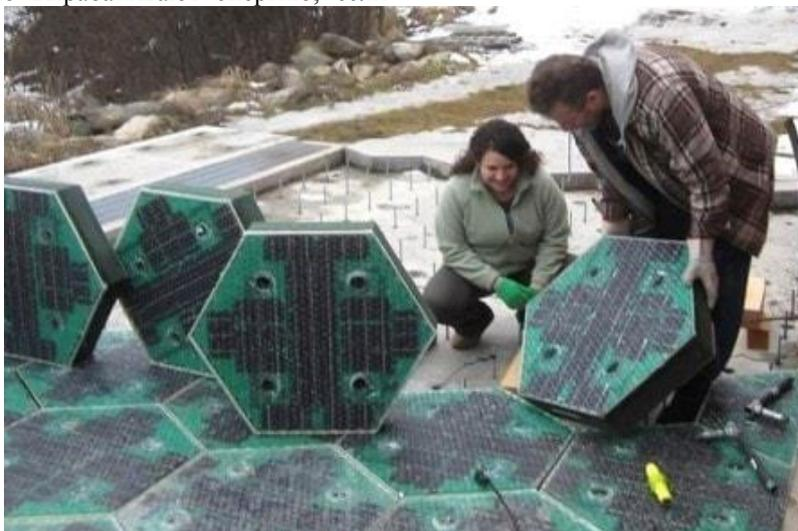
*Рисунок 2. Шестигранные панели покрытия*
