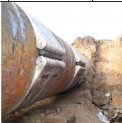
Рисунок 2 – Муфта PCM
