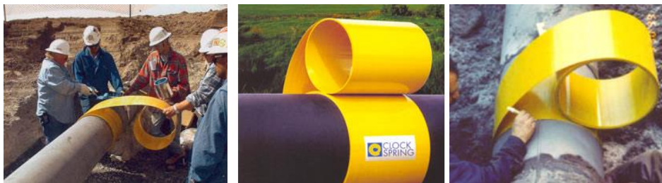
Рисунок 1 – Монтаж муфти Clock Spring
