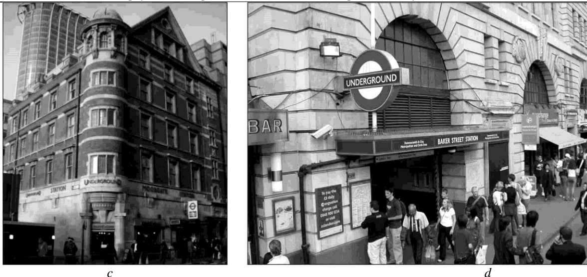
Рис. 1. Виходи з метрополітену інтегровані в забудову: а – верхній вихід з метро “Хрещатик” в м. Києві; б – вихід з метро “Золоті Ворота” в м. Києві; с – вихід з метро “Мургейт стейшн” в м. Лондоні; д – вихід з метро “Беккер стріт” в м. Лондоні.
