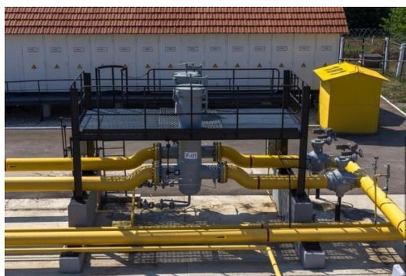
Рис. 2. Трубопроводи з аміаком на території насосної станції
