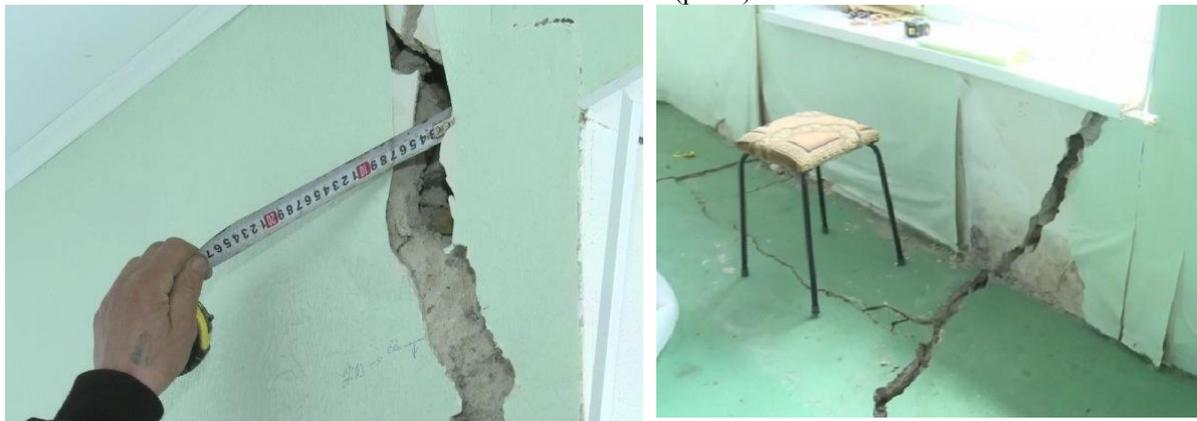
Рис.3 Разрушение несущих конструкций дома в селе Маркэуць.
