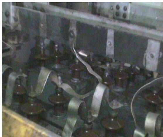
Рисунок 2 Нагрев вывода конденсатора до 61°C
