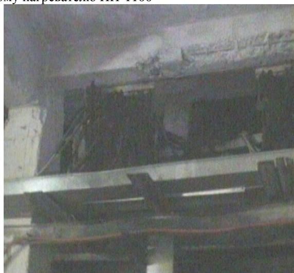
Рисунок 1. Нагрев питающей кабельной линии до 144°C
