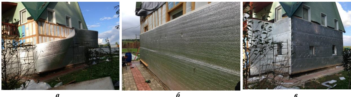
Рис. 10. Теплоизоляция коттеджа:
