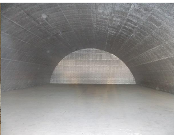
Рис. 5. Изоляция бескаркасного помещения. Крытый скотный двор
