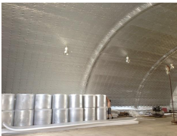
Рис. 5. Изоляция бескаркасного помещения. Крытый скотный двор
