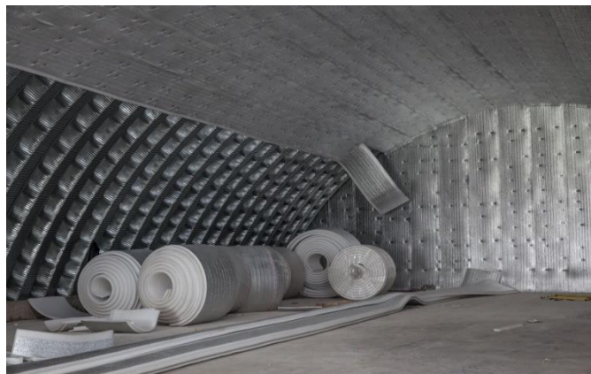
Рис. 6. Формирование изоляции торца овощехранилища
