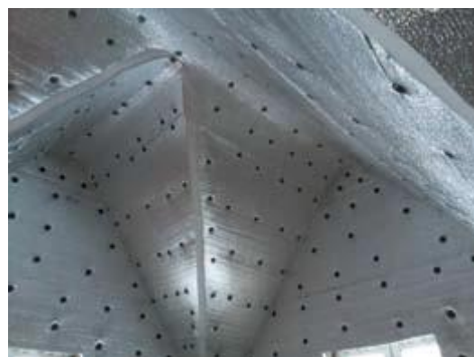
Рис. 11. Формирование изоляционной оболочки на кровле
