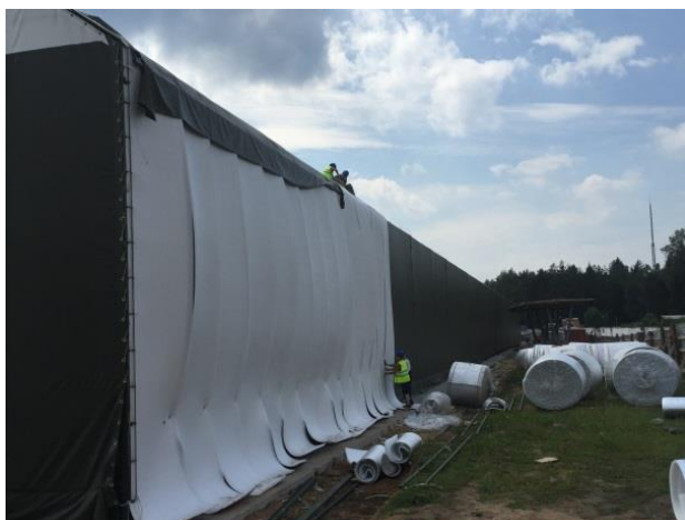
Рис. 9. Монтаж тентового покрытия
