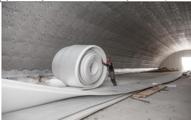
Рис. 2. Подготовка рулона из металлизированного вспененного полиэтилена
